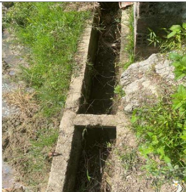
Mương bê tông hiện trạng
