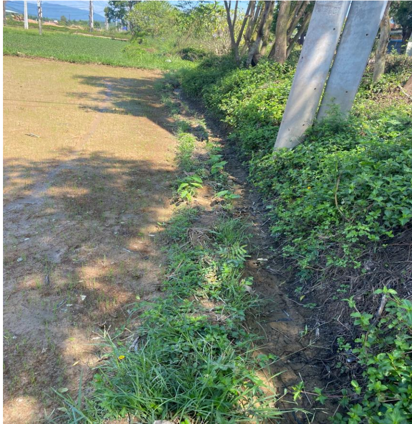
Hình 3.4. Mương hiện trạng dọc Quốc lộ 19
