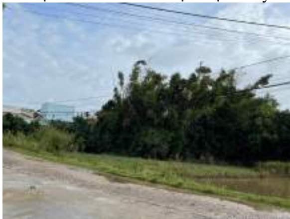
Hiện trạng đường BTXM phía Đông Bắc dự án
