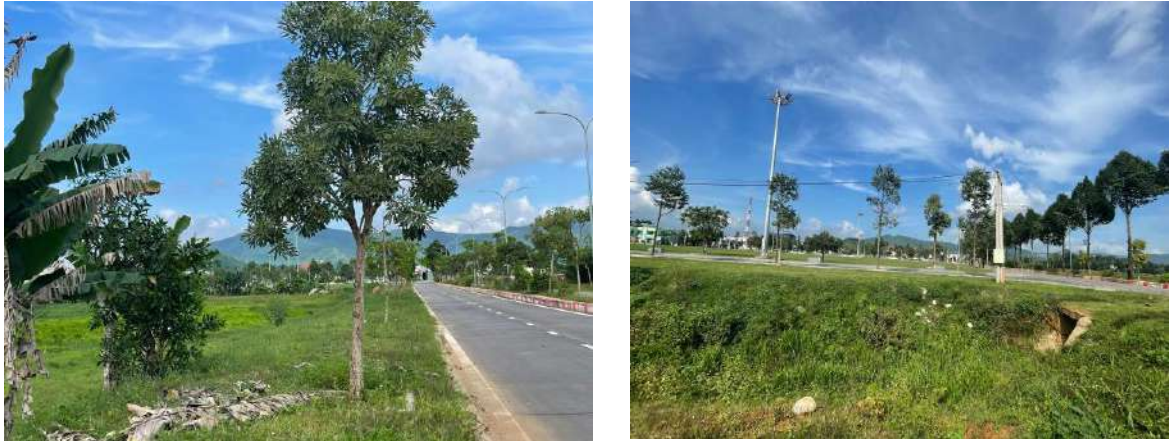
Hình 1.3. Hiện trạng đường giao thông dự án
