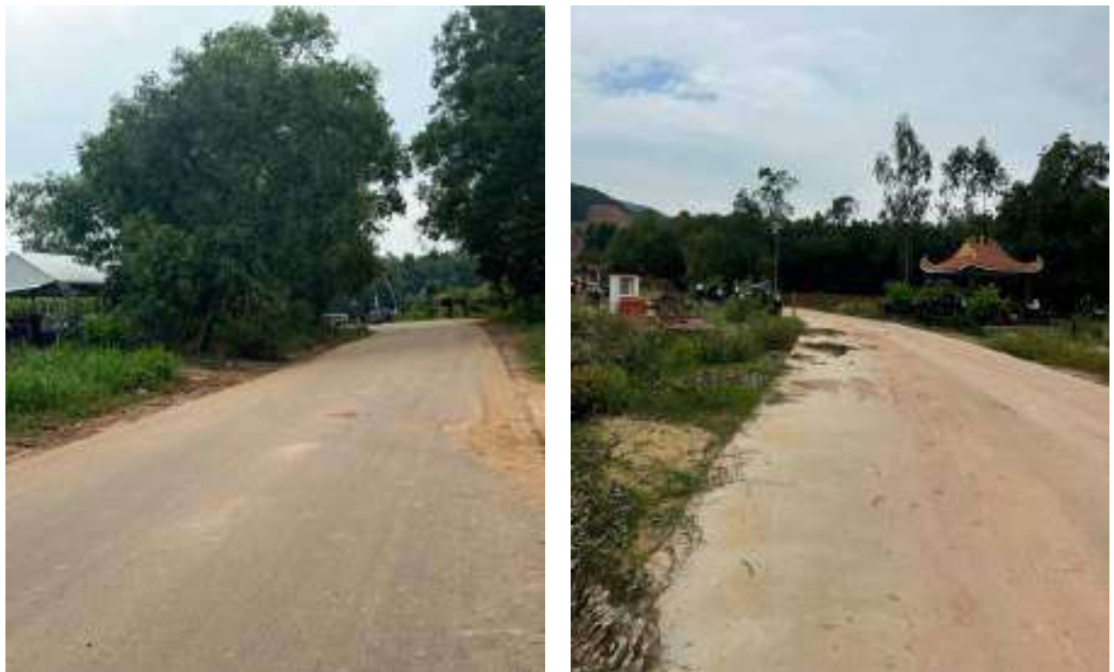
Hình 1.3. Hiện trạng đường ĐT639B và đường vào mỏ đất
