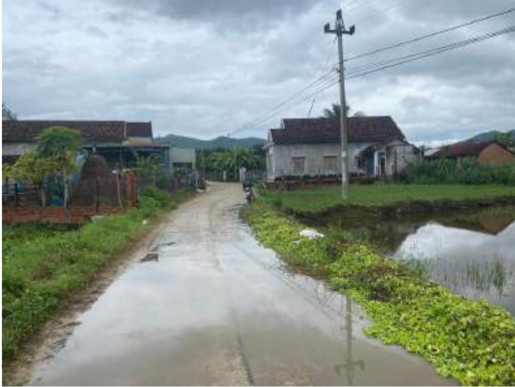
Hình 1.4. Hiện trạng tuyến đường ĐH29
