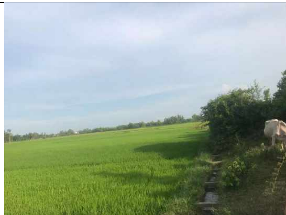
Mương bê tông kích thước 0,6x0,8x0,12m
