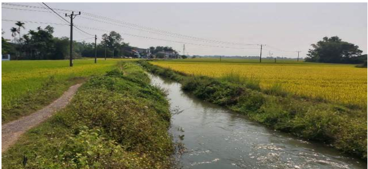
Hình 1.5. Tuyến mương tưới tiêu chính trong khu vực Dự án
