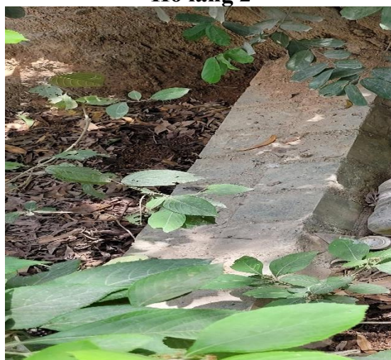
Đoạn kè giảm tốc trên mương
