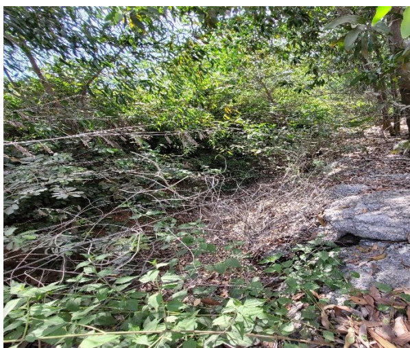
Mương thoát nước
