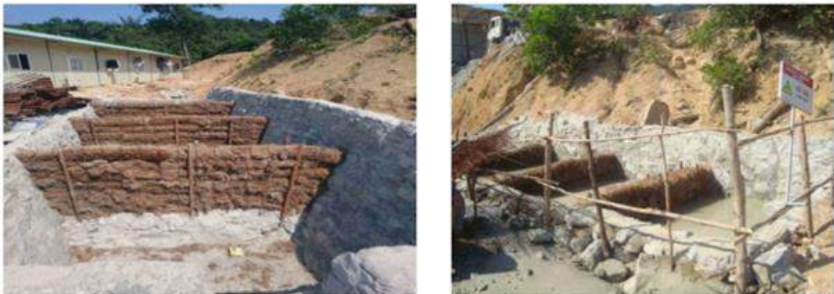
Hình 3.1. Mặt bằng hồ lắng xử lý nước thải thi công bằng vật liệu lọc Hình ảnh thực hiện trong thực tế như sau:
