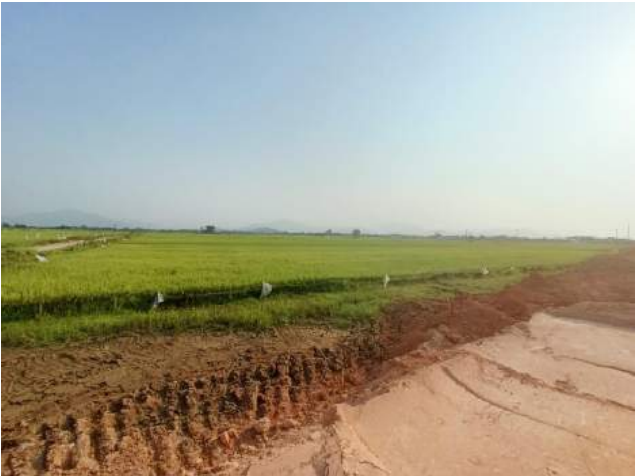
Hình 1.2 Hình ảnh hiện trạng của khu vực thực hiện dự án
