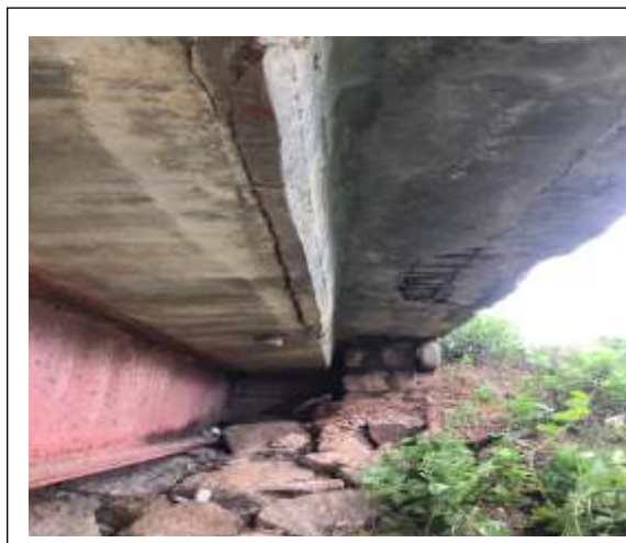
Hình 1.4. Bản mặt cầu bị nứt, bong tróc và gỉ thép
