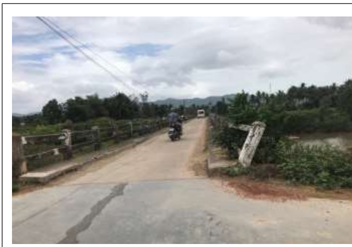
Hình 1.3. Lan can, tay vịn bị nghiêng, gãy
