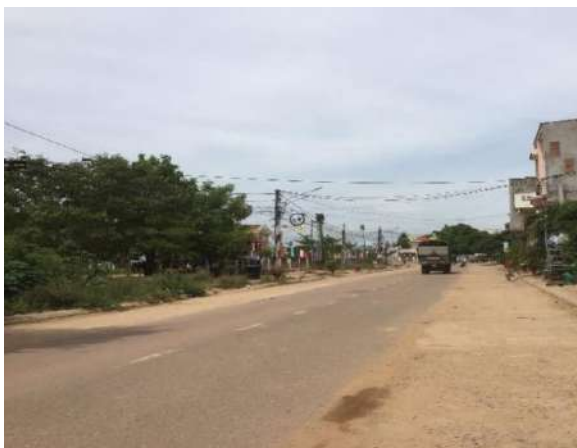
Hiện trạng đường ĐT.631
