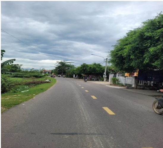
Hình tuyến đường hiện hữu
