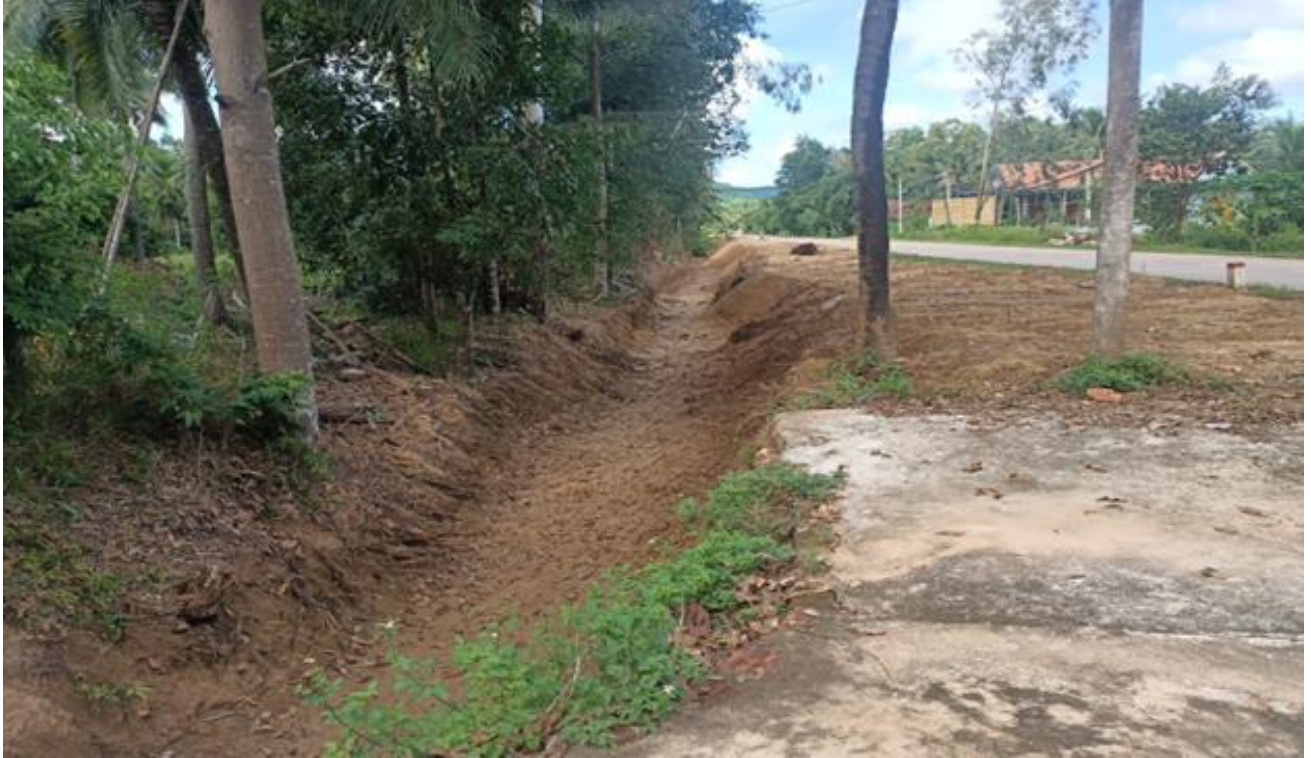
Hình 1.4. Vị trí kênh mương hiện trạng khu vực dự án
