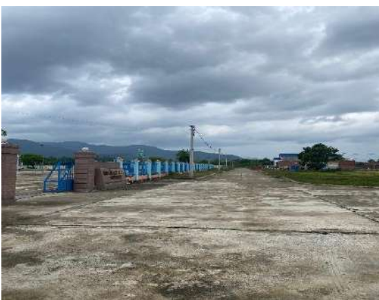
Hiện trạng đường BTXM phía Bắc dự án
