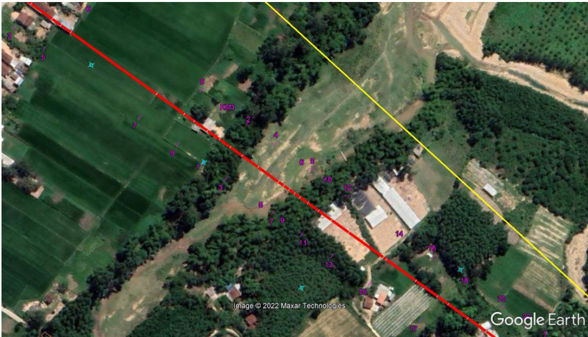
Hình 1.4. khu vực sông An Tượng lý trình Km2+954.80-Km3+43.30 đoạn dự án đi qua
