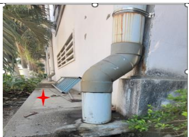
Mương và ống thu gom nước mưa trên mái
