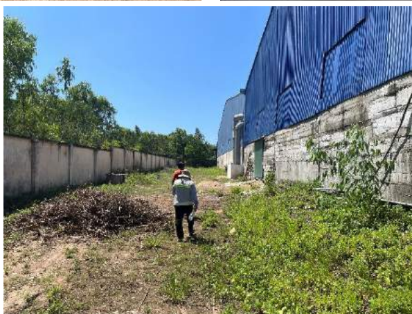
Hình 1. 2. Hiện trạng nhà xưởng và khu vực xung quanh dự án
