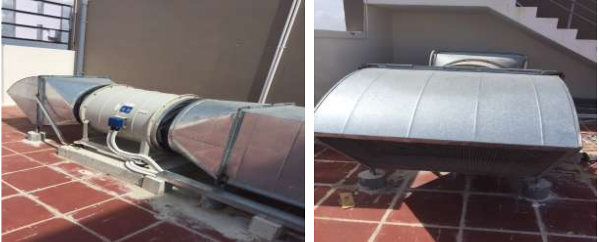
Hình 3. 6. Quạt tạo áp cầu thang bộ
