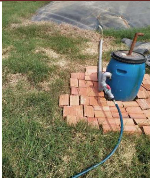
Hệ thống thu khí hầm biogas
