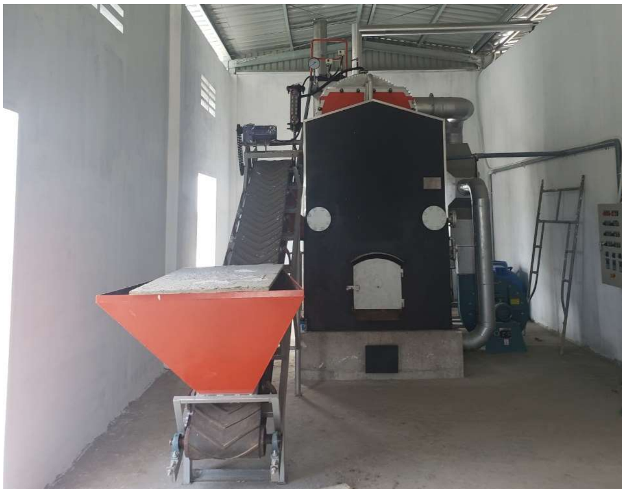
Hình 3. 12. Lò hơi và hệ thống xử lý khí thải
