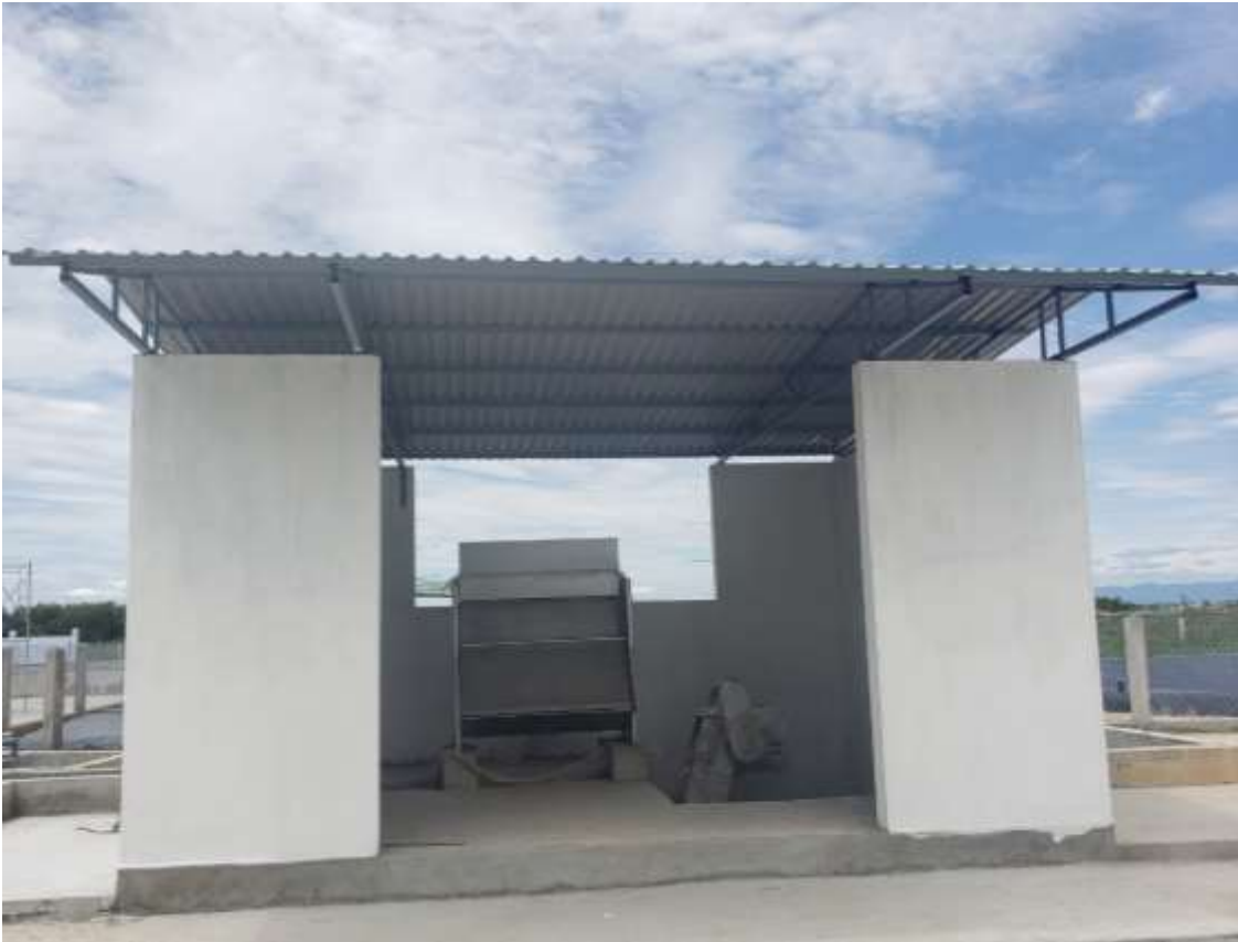
Hình 3. 14. Nhà chứa CTR và đặt máy ép phân
