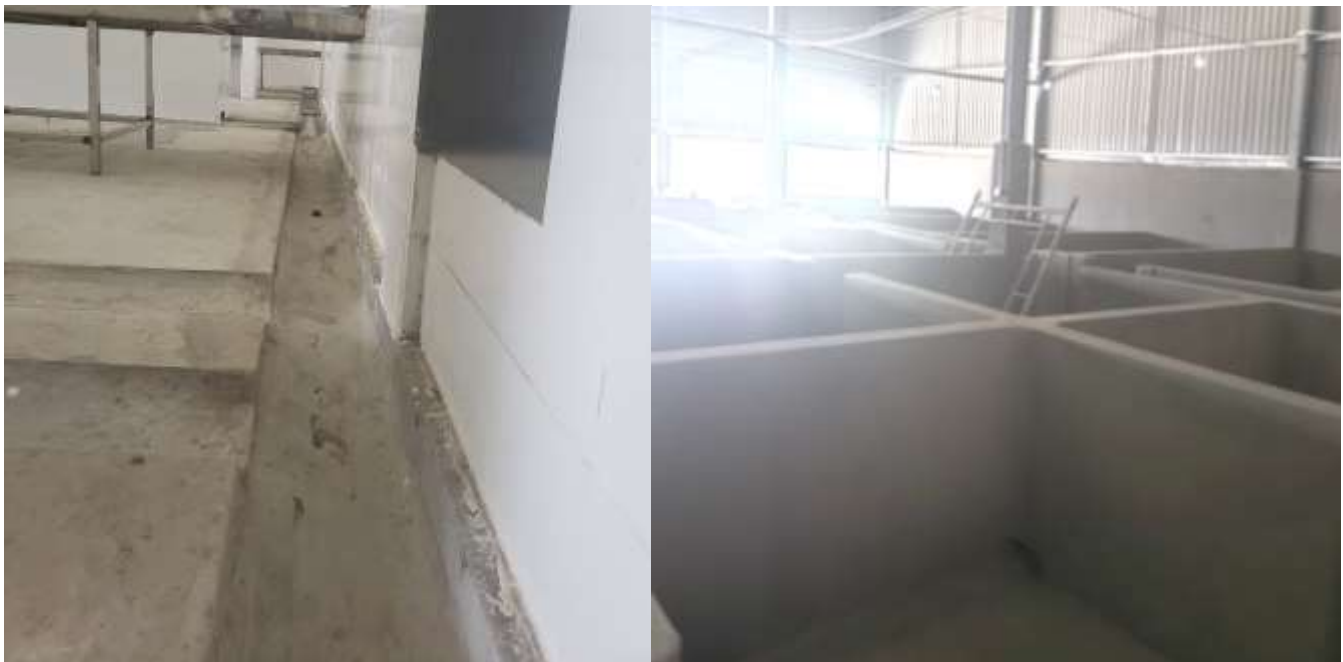
Hình 3. 5. Rãnh thu nước thải dọc theo vách các khu giết mổ, khu nhốt gia súc
