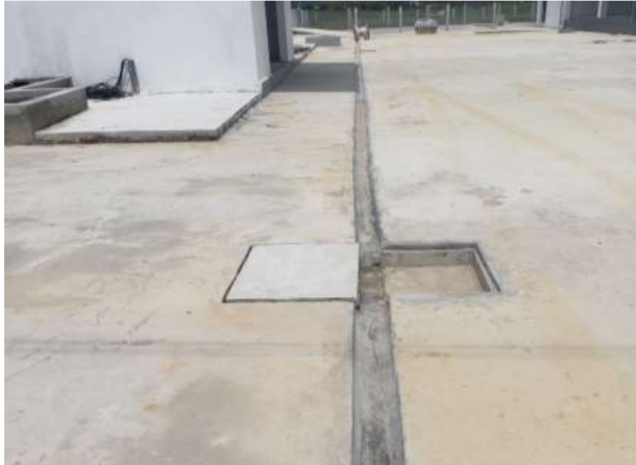
Hình 3. 2. Rãnh thu nước mưa trên phần sân xi măng
