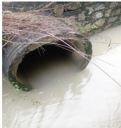
Điểm thoát nước mưa phía Nam
