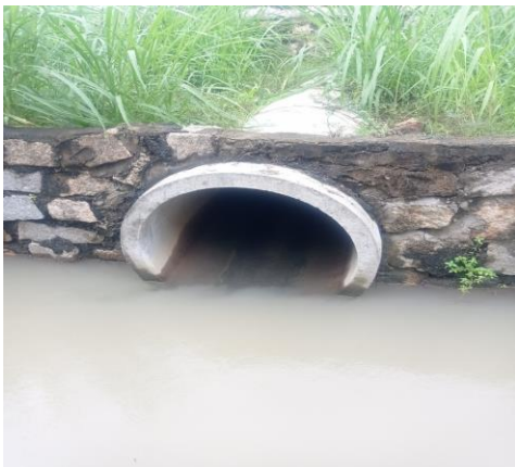
Điểm thoát nước mưa phía Nam
