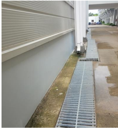
Mương thu gom nước mưa
