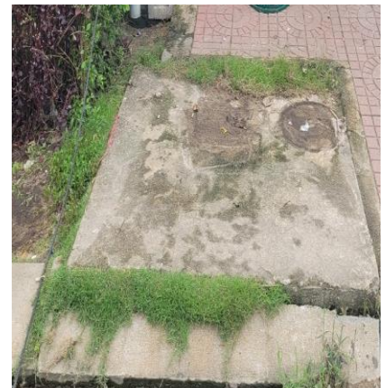
Điểm thoát nước mưa phía Bắc
