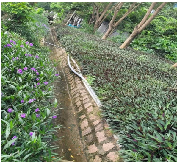
Mương thu gom nước mưa tại nhà máy
