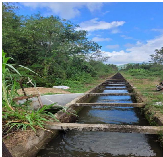
Mương thủy lợi phía Đông nhà máy
