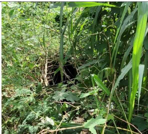
Điểm thoát nước mưa phía Tây Nam Nhà máy
