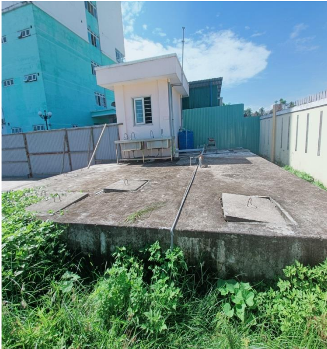
Khu vực xây dựng HTXLNT
