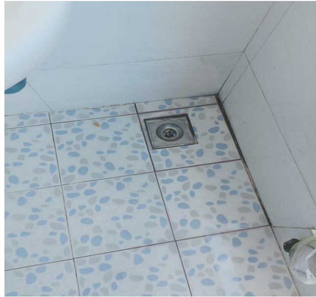
Phễu thu nước ban công
