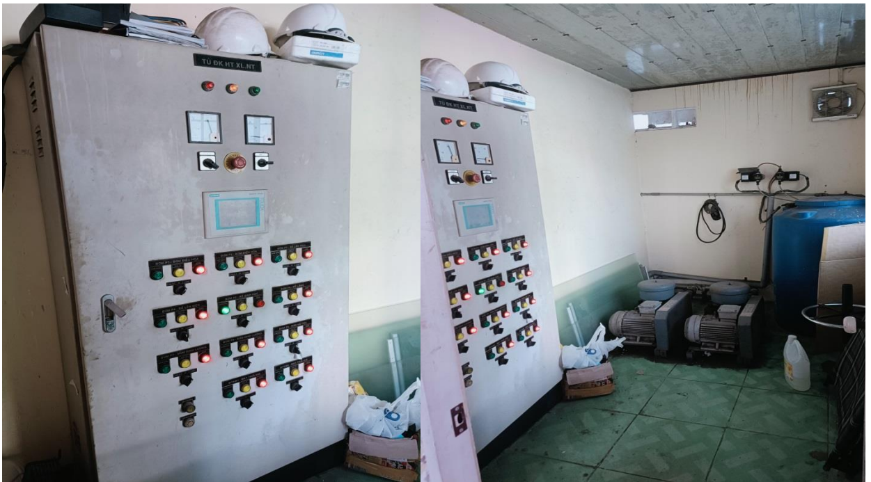
Nhà điều hành hệ thống xử lý nước thải
