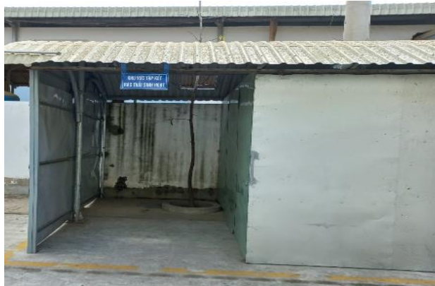
Hình: Khu vực tập kết CTR sinh hoạt
