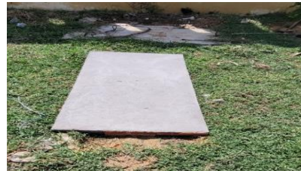
Hình 3.6: Hồ ga đầu nổi nước thải sinh hoạt với hạ tầng CCN
