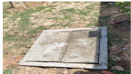
Hình 3.5: Hồ ga đầu nối nước thải bãi chứa gỗ với hạ tầng CCN
