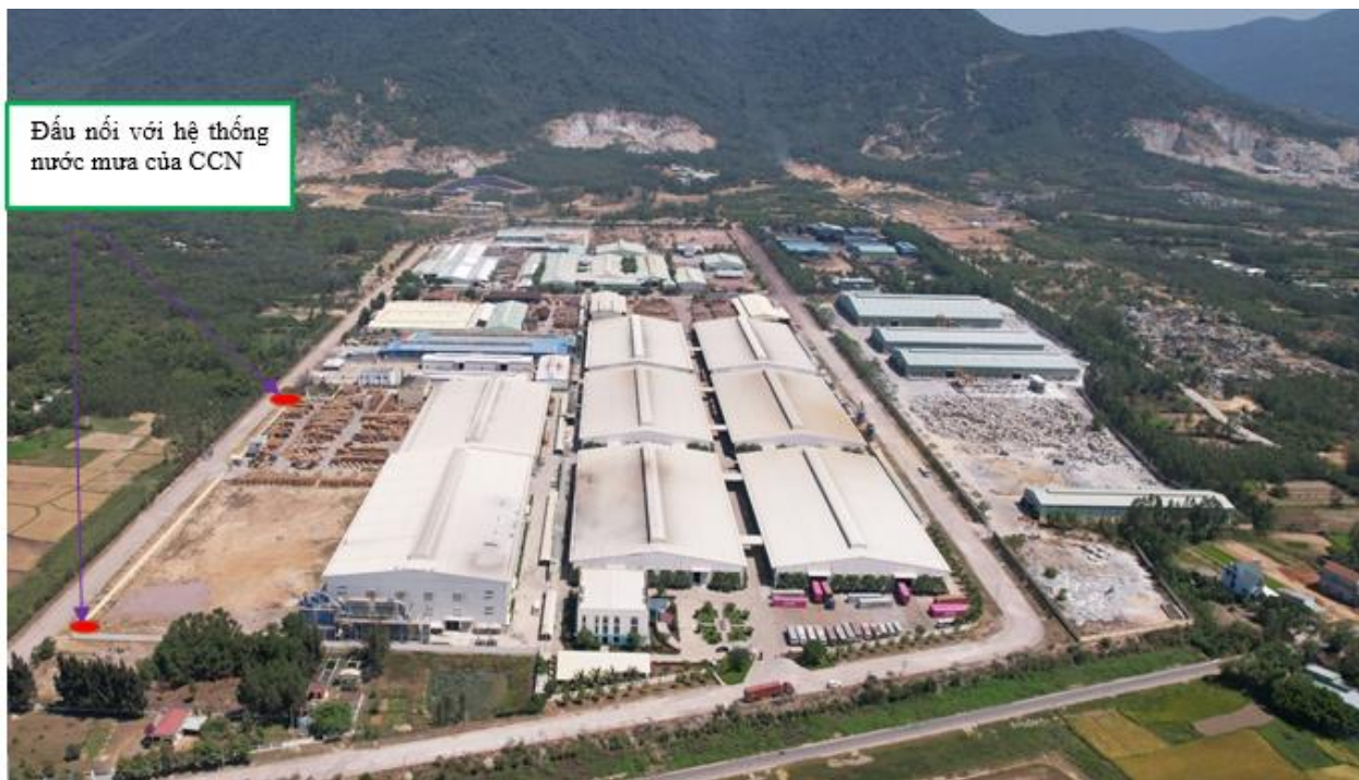
Hình: Vị trí đầu nối nước mưa chảy tràn tại nhà máy với hệ thống thoát nước mưa của CCN
