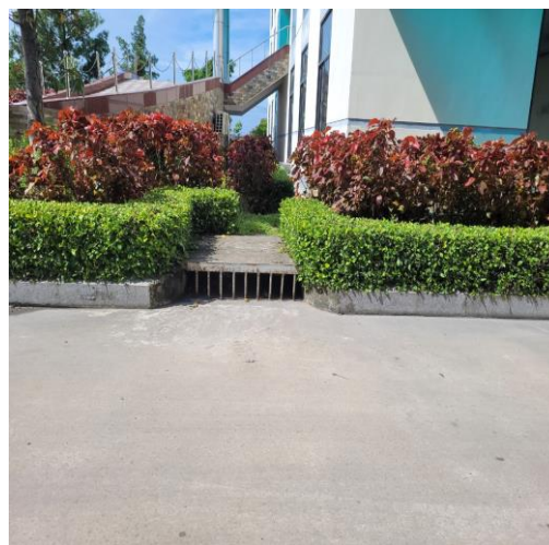
Hình 3.1: Điểm thu gom nước mưa tại nhà máy
