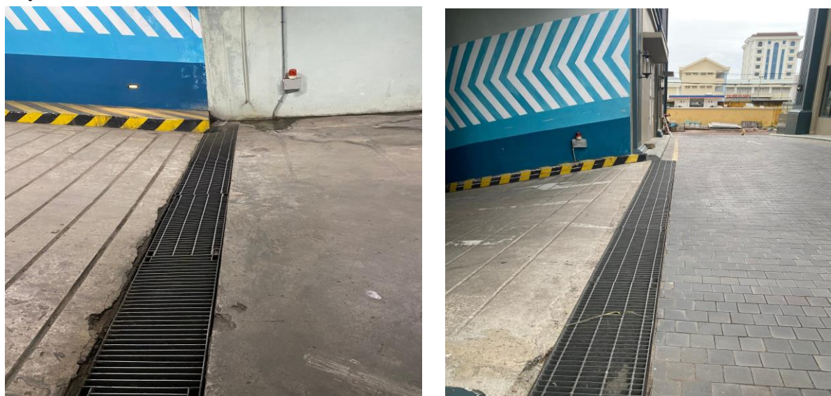
Hình 3.3. Mương thu nước dầy đan
