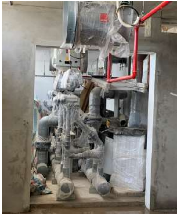
Hình 3.14. Hệ thống lọc nước hồ bơi
