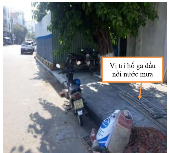
Hình 3.4. Vị trí hố ga đầu nối nước mưa của dự án, nằm trên vỉa hè đường Nguyễn Huệ
