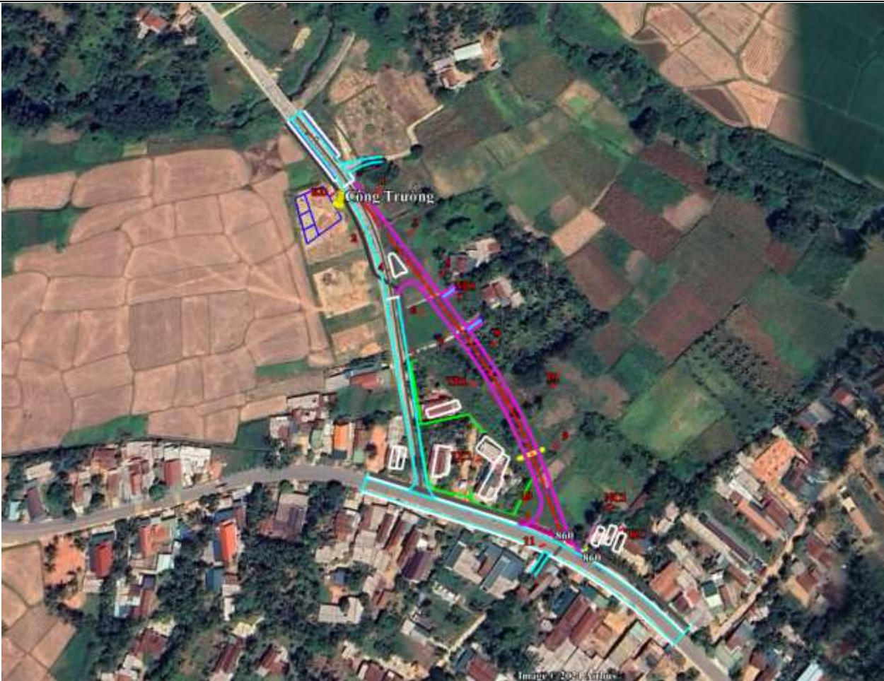
Hình 1.6. Vị trí bố trí công trình thi công
